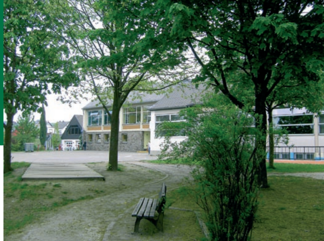
Beispiel Grundschule Farschweiler
