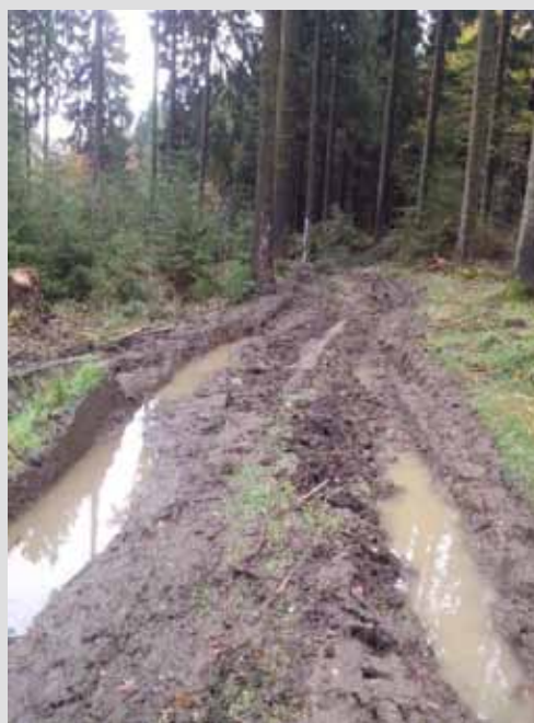
Gleisbildung nach Maschineneinsatz auf Befahrungslinie der Feinerschließung. Foto: F. Schmidt
